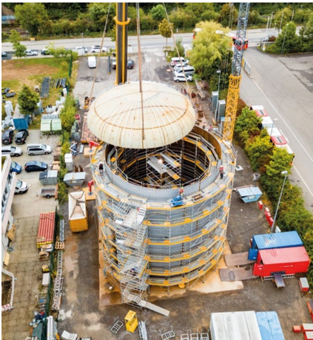
Hier wird das Dach des Wärmespeichers aufgesetzt
