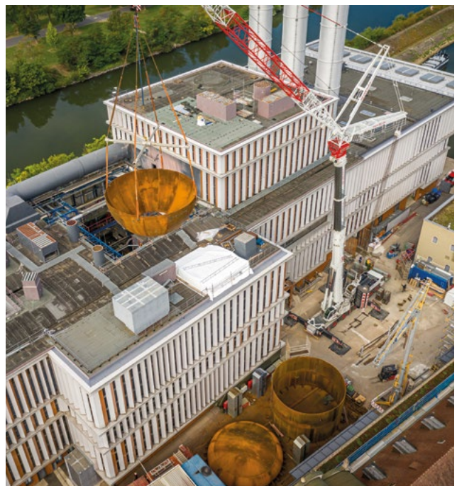
Einheben des neuen Wärmespeichers in das Heizkraftwerk Würzburg
