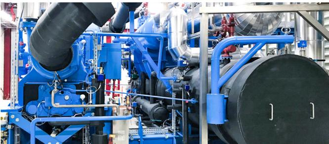
Die Jungbunzlauer Austria AG hat unlängst zwei Wärmepumpen der Friotherm AG mit je 10 MW Heizleistung installiert. Die bei Kremsmüller in Steinhaus gefertigten Großwärmepumpen gewinnen aus dem exotherm verlaufenden Fermentationsprozess anfallende Wärme zurück und erzeugen Heißwasser.
